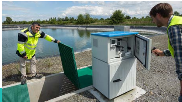
Hirel, réhabilitation des lagunes
