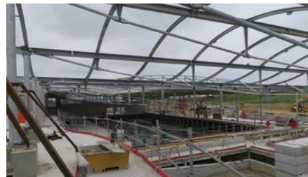
Fin de construction de la charpente et montage de la couverture
