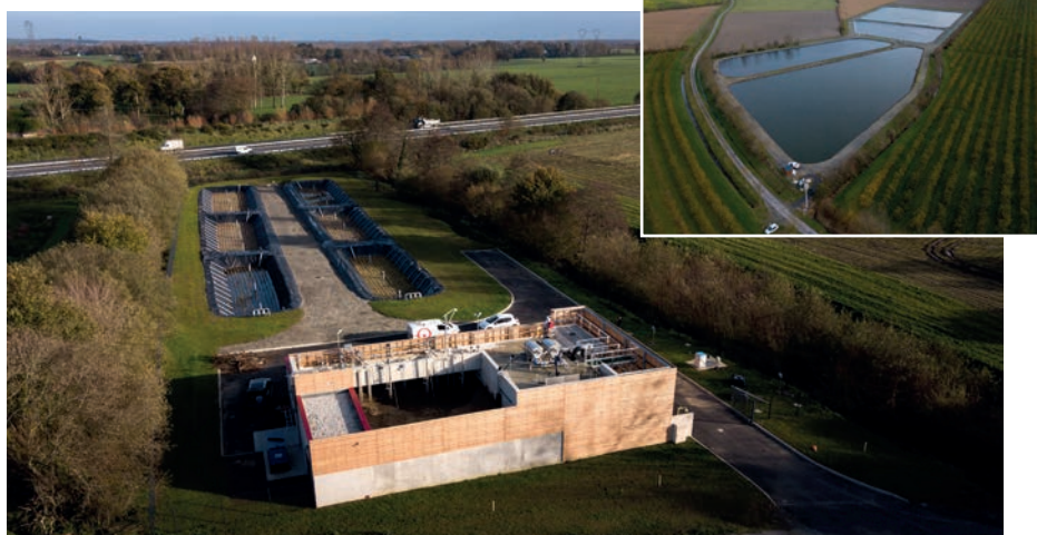
La nouvelle STEP de la ZAC Actipole à Miniac-Morvan. En médaillon, la station réhabilitée d'Hirel-Bourg.
