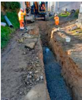
Remplacement de canalisations des eaux pluviales à Plerguer
