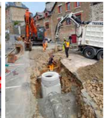
Remplacement de canalisations des eaux pluviales à Cancale
