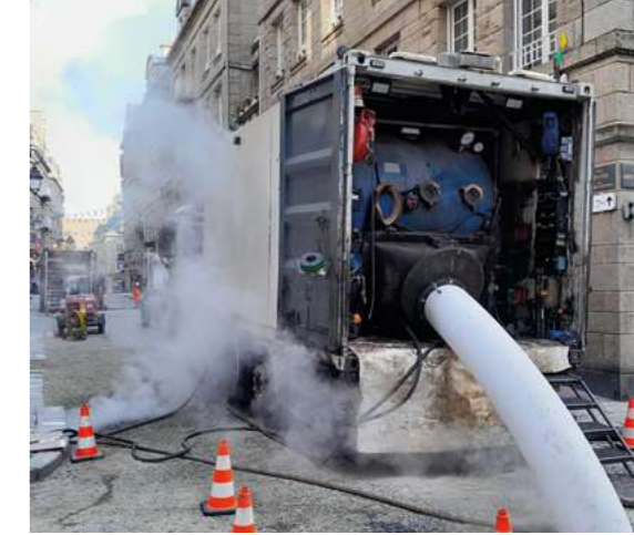
Travaux de chemisage à Saint-Malo Intra-Muros
