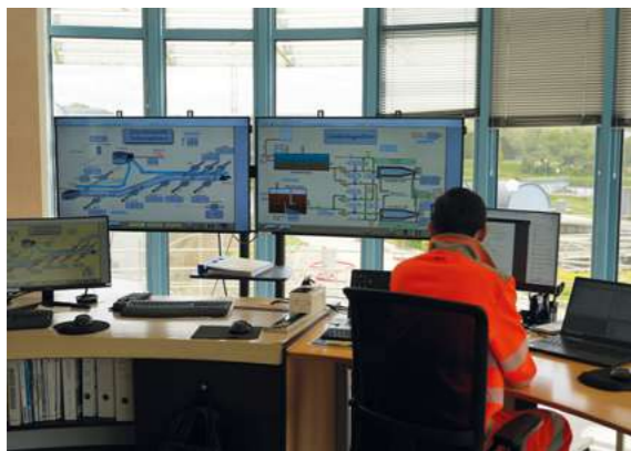
Le poste de contrôle de l'assainissement en temps réel, à la station d'épuration de Saint-Malo.
